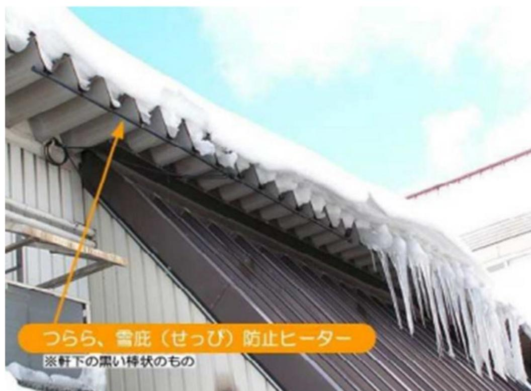
消雪消雪用散水設備に加え、倉庫に関しても積雪を考慮した屋根の設計ならびに融雪ヒーターを設置
